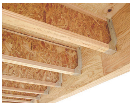
写真 6-17 I-ジョイストの施工例（カラマツ LVL をフランジに、ウェブに面材（OSB）を使用、提供：(一社)全国 LVL 協会、(株)キーテック）
