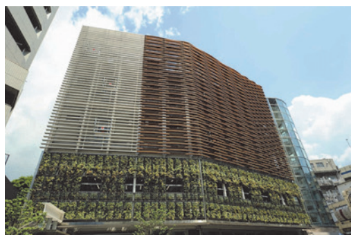
写真 5-19 港区麻布図書館のルーバー（平成 26 年竣工、熱処理したスギ材に塗装）
