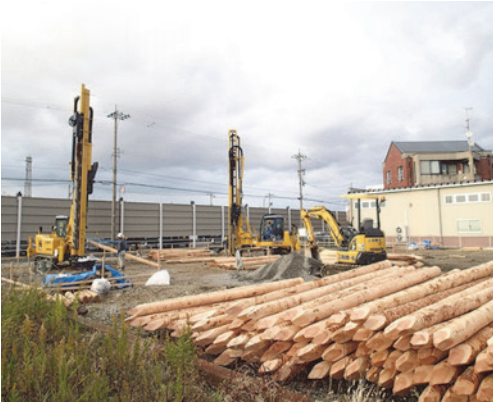
写真 5-21 木杭による液状化対策の施工（提供：沼田淳紀氏、飛鳥建設(株)）
