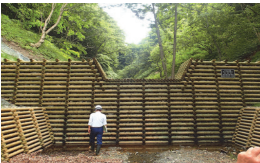
写真 5-23 木製校倉式ダム工（由利本荘市、平成 25 年設置、提供：佐々木貴信氏、秋田県立大学）
