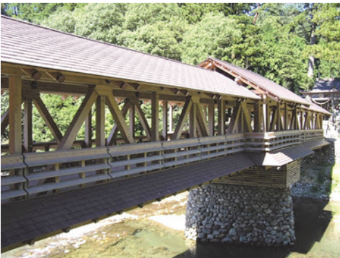
写真 5-22 屋根付木造橋「御幸橋」（高知県梼原町、平成 14 年竣工、提供：渡辺浩氏、福岡大学木橋資料館）
