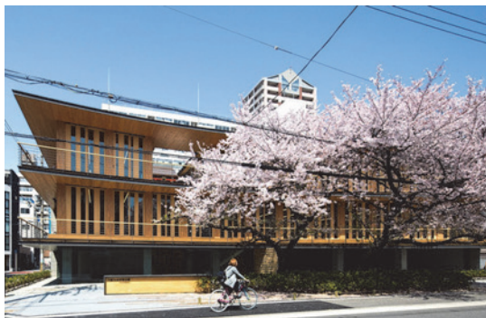
写真 5-1 大阪木材仲買会館（木のぬくもりに会えるオフィスビルとして平成25年に竣工）
