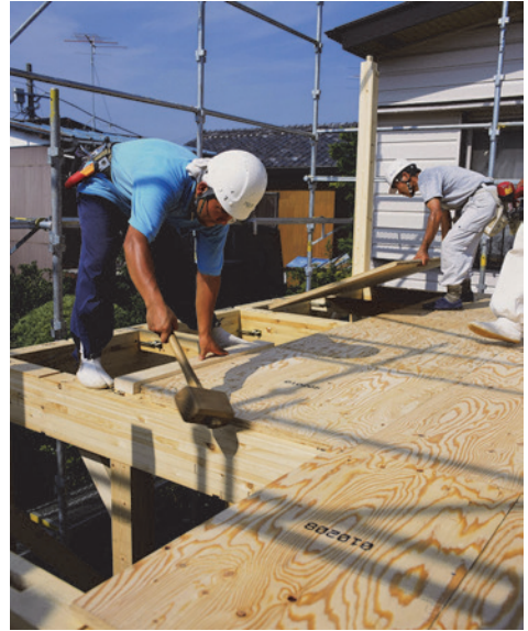
写真 6-12 構造用合板（ネダノン）による2階床の施工（提供：日本合板工業組合連合会、東京・東北合板工業組合）
