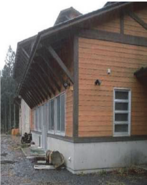
写真 5-6 基礎が高く軒の出が大きい建築物 (8)
