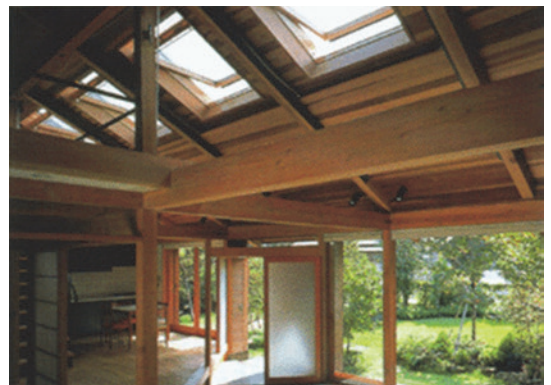
写真 5-12 木製窓枠をたくさん使った住宅（提供：（一社）日本木製サッシ工業会）
