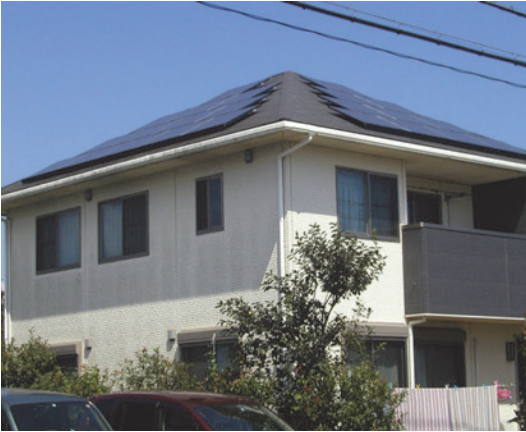
写真 5-15 東、南、西の3面にソーラーパネルを備えた住宅
