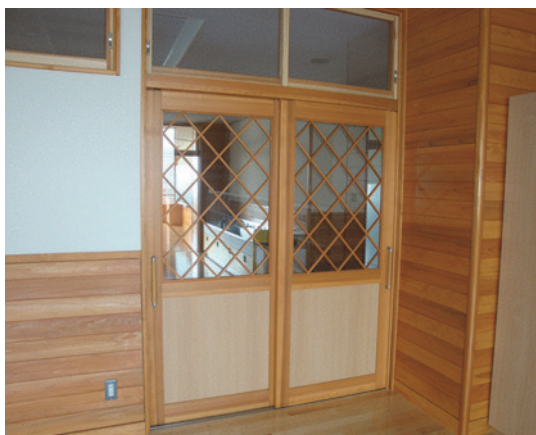
写真 6-10 木製建具の引き戸（横手市立横手北小学校、 提供：全国建具組合連合会、(株)小松木工）
