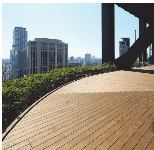
写真 5-18 中之島フェスティバルタワーのデッキ（平成 24 年竣工、樹脂含浸した LVL に塗装）
