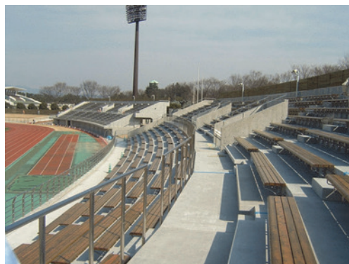
写真 5-20 正田醤油スタジアムの観覧席ベンチ（前橋市、平成 18 年設置、木材保存剤を加圧注入処理し塗装、提供：佐々木木材防腐(株)）
