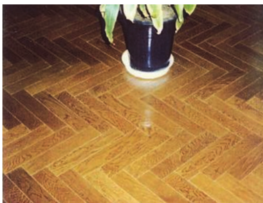
写真 5-13 京都大学木質ホールの木質床材（平成6年竣工、化学加工と塗装を施し、土足歩行ながら現在も美観を保っている）
