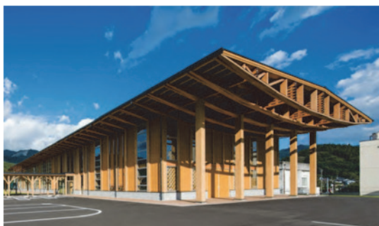
写真 6-2 住田町庁舎（岩手県気仙沼郡住田町・公共建築物における木材利用優良事例 (4) ）
