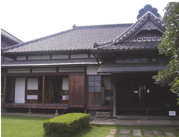
写真 5-9 佐倉順天堂記念館（1858年に建築された蘭医学の塾兼診療所、束柱の下に沓石が据えられている）
