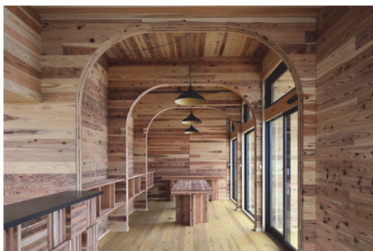
写真 5-11 断熱性と遮音性のある CLT を使用した室内（提供：日本 CLT 協会、(株)三東工業社、杉野圭氏撮影）
