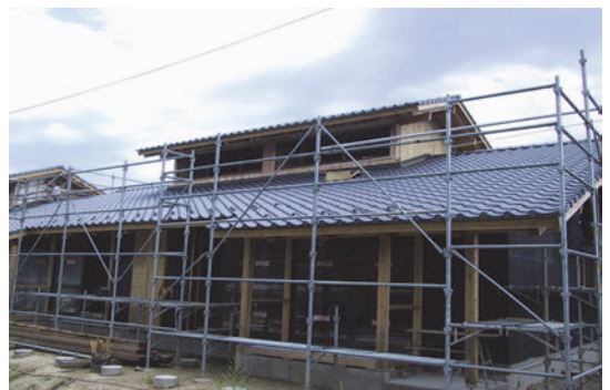
写真 6-1 建築中の市営住宅（岩手県遠野市鶯崎 6 団地の二軒長屋） (3)
