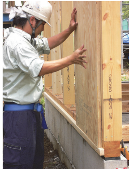
写真 5-10 厚物合板による耐力壁の施工の様子（提供：日本合板工業組合連合会、東京・東北合板工業組合）
