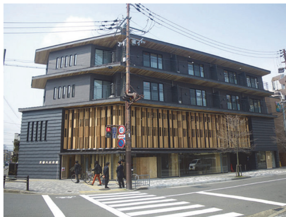
写真 5-5 木造4階建ての京都木材会館（2時間耐火の木質耐火部材を使用した建物） (7)
