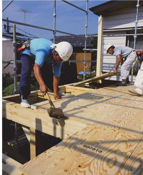
写真 12 構造用合板（ネダノン）による2階床の施工（提供：日本合板工業組合連合会、東京・東北合板工業組合）
