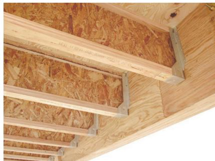
写真 17 I-ジョイストの施工例 (カラマツ LVL をフランジに、ウェブに面材 (OSB) を使用、提供：(一社)全国 LVL 協会、(株)キーテック)
