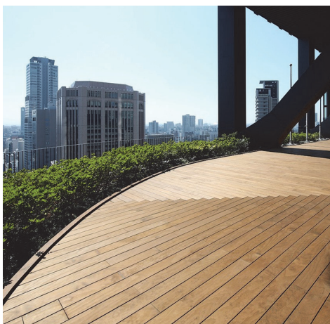
写真 18 中之島フェスティバルタワーのデッキ（平成 24 年竣工、樹脂含浸した LVL に塗装）
