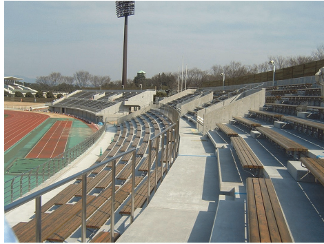
写真 20 正田醤油スタジアムの観覧席ベンチ（前橋市、平成 18 年設置、木材保存剤を加圧注入処理し塗装、提供：佐々木木材防腐(株)）
