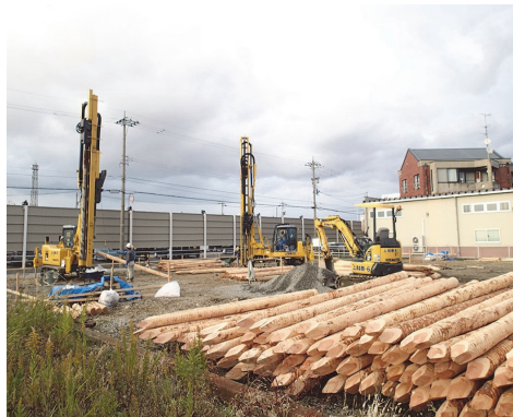
写真 21 木杭による液化化対策の施工（提供：沼田淳紀氏、飛鳥建設(株)）
