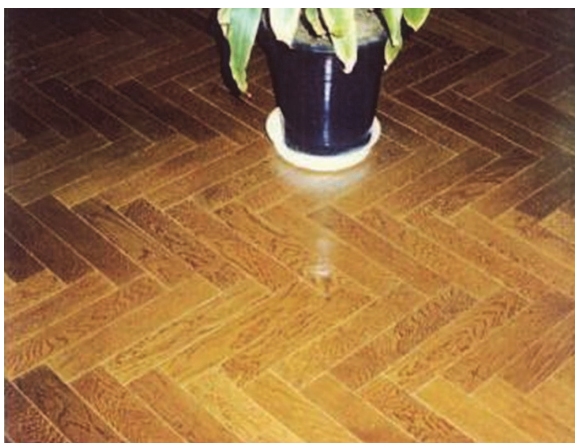
写真 13 京都大学木質ホールの木質床材（平成 6 年竣工、化学加工と塗装を施し、土足歩行ながら現在も美観を保っている）
