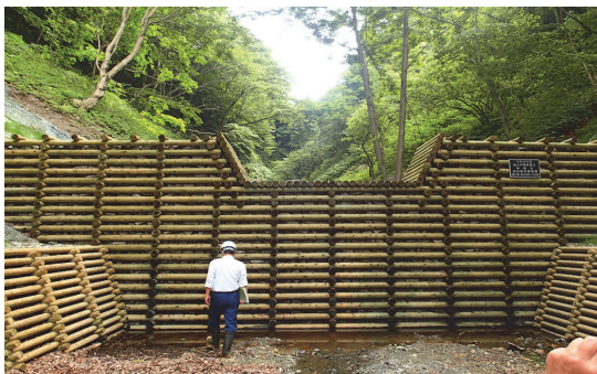
写真 23 木製校倉式ダム工(由利本荘市、平成 25 年設置、提供: 佐々木貴信氏、秋田県立大学)
