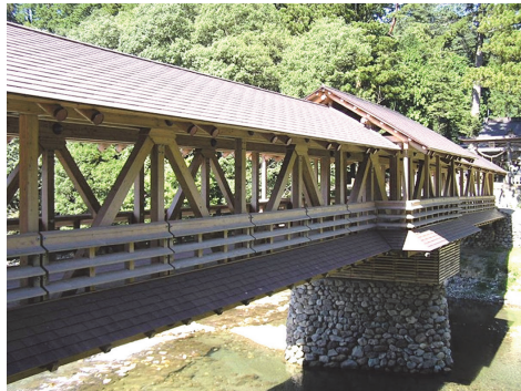
写真 22 屋根付木造橋「御幸橋」（高知県梶原町、平成 14 年竣工、提供：渡辺浩氏、福岡大学木橋資料館）
