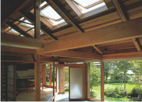
写真 12 木製窓枠をたくさん使った住宅（提供：（一社）日本木製サッシ工業会）
