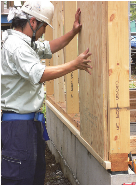
写真 10 厚物合板による耐力壁の施工の様子 (提供：日本合板工業組合連合会、東京・東北合板工業組合)
