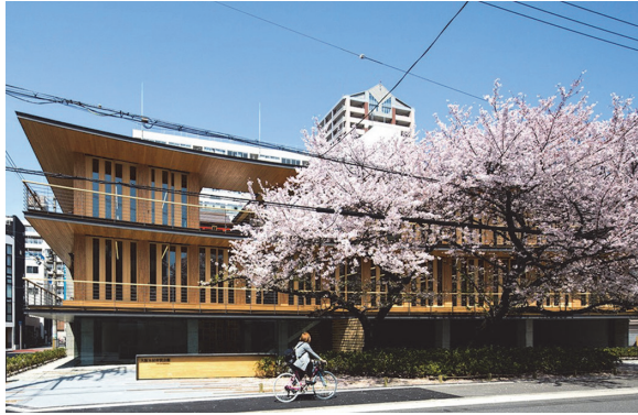
写真 1 大阪木材仲買会館（木のぬくもりに会えるオフィスビルとして平成 25 年に竣工）
