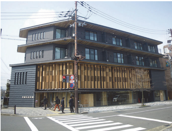
写真 5 木造4階建ての京都木材会館（2時間耐火の木質耐火部材を使用した建物） (7)
