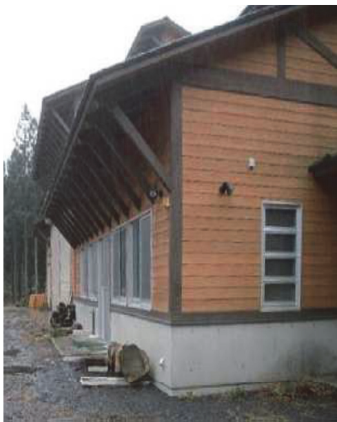
写真 6 基礎が高く軒の出が大きい建築物 ⑧
